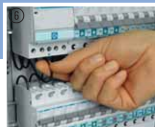
Повышенная безопасность благодаря конструкции с защитой от прикосновения (токоведущие части защищены от непреднамеренного прикосновения)
