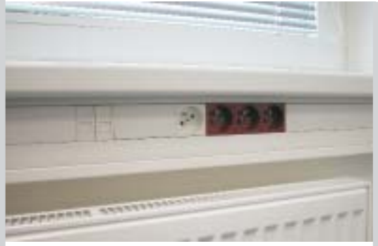
Пример монтажа подоконного канала PK 120X55 D.
