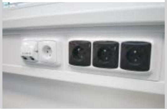
Пример монтажа подоконного канала PK 140X70 D.
