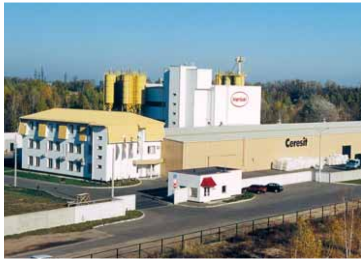
Завод по производству сухих строительных смесей, г. Вышгород.
