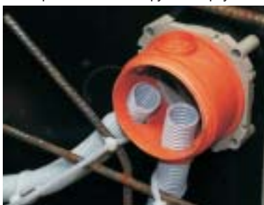
Смонтированные гибкие трубки в корпусе KBT.
