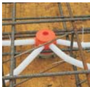
Пример использования в горизонтальной опалубке.
