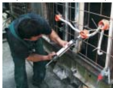
Герметизация вводов (шпатлёвка).
