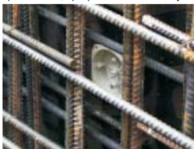
Крышка KBV, прикрепленная на опалубке.
