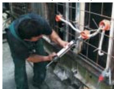
Utěsnění prostupů (tmel).
