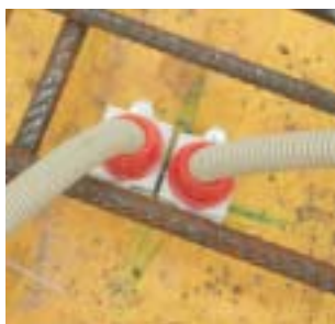
Příklad použití vývodky a koncovky.
