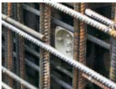
Víčko KBV připevněné na bednění.
