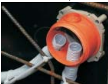
Namontované ohebné trubky do tělesa KBT.
